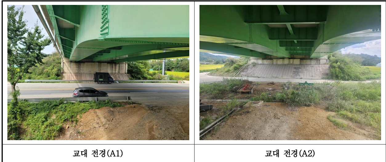
【사진 5.3.8】 교대 전경
