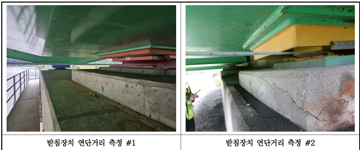
【사진 5.3.14】 교량받침장치 연단거리측정
