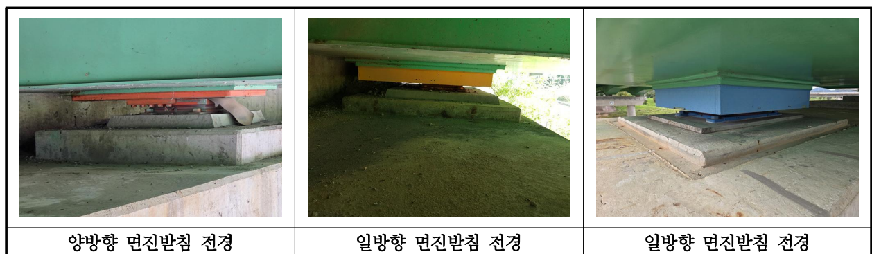
【사진 5.3.12】 교량받침 전경
