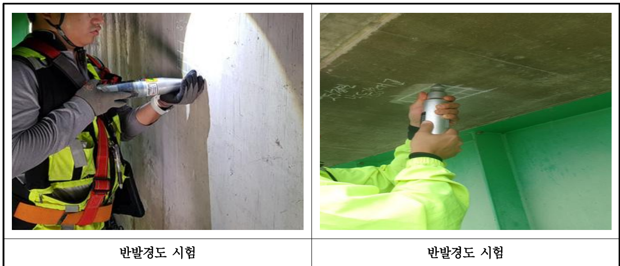
【사진 5.4.2】 반발경도시험 현장사진
