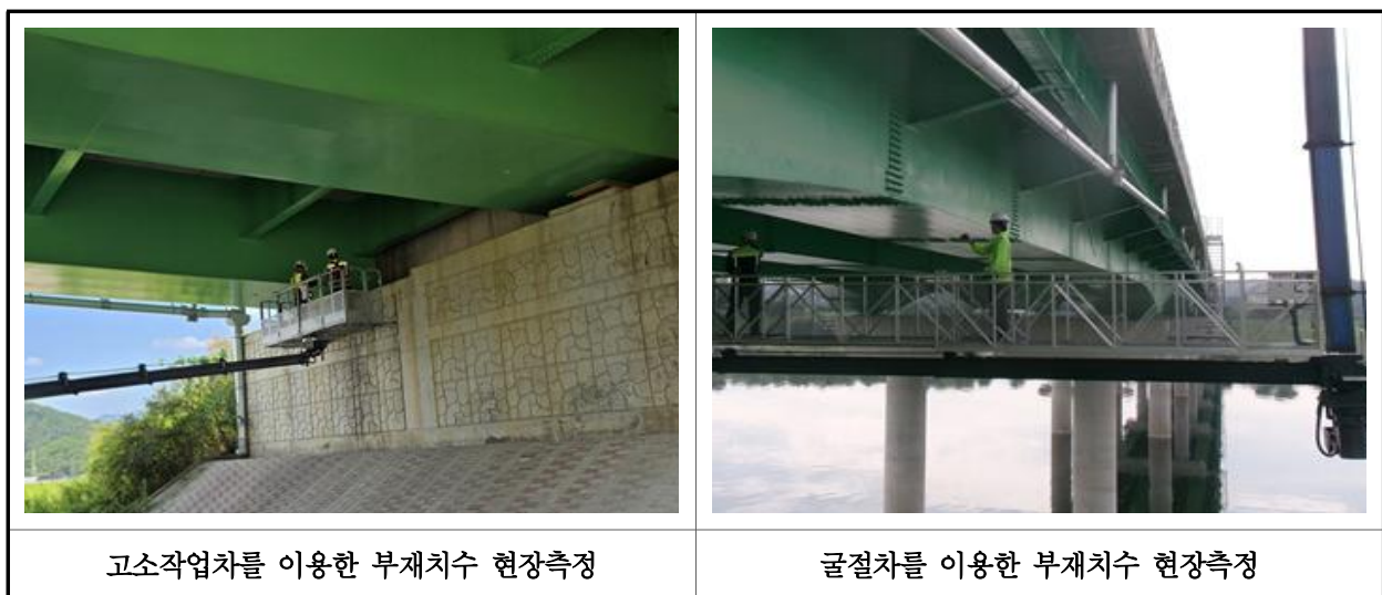
【사진 5.2.1】 부재 현장측정 전경
