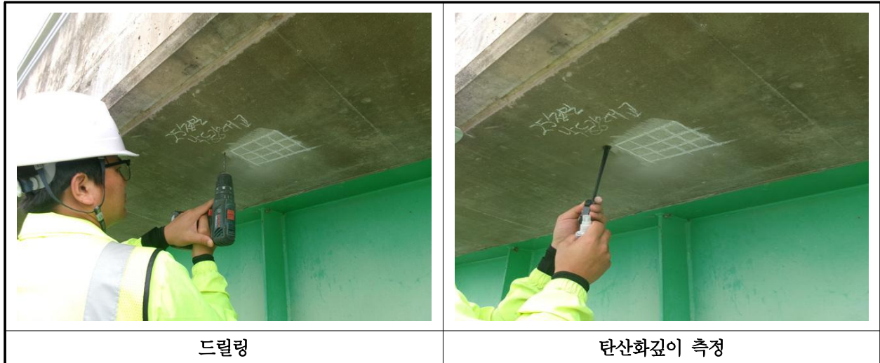
【사진 5.4.3】 탄산화 깊이 측정 현장사진
