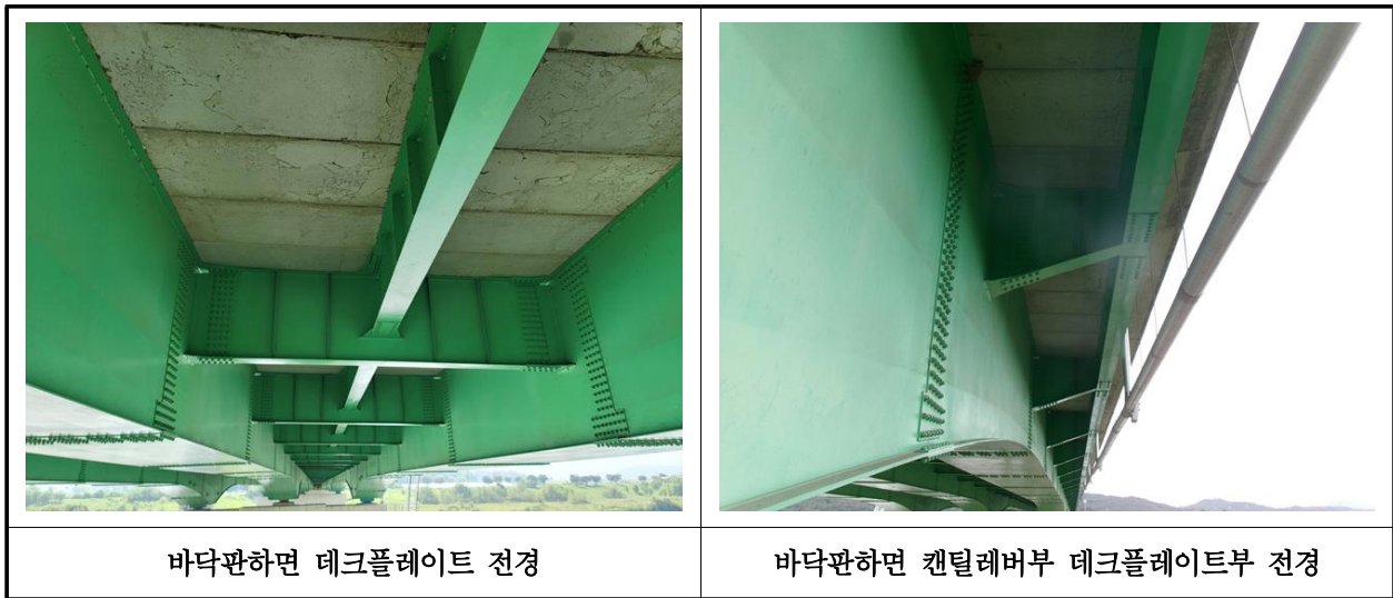
【사진 5.3.2】 바닥판하면 전경
