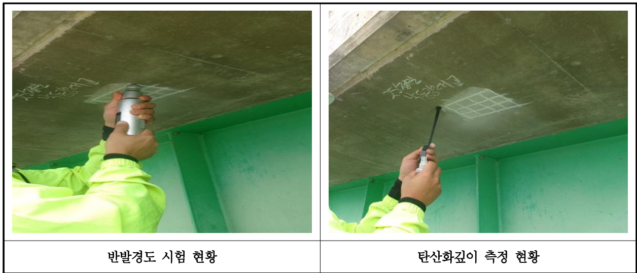
【사진 5.4.1】 콘크리트 내구성조사 현황
